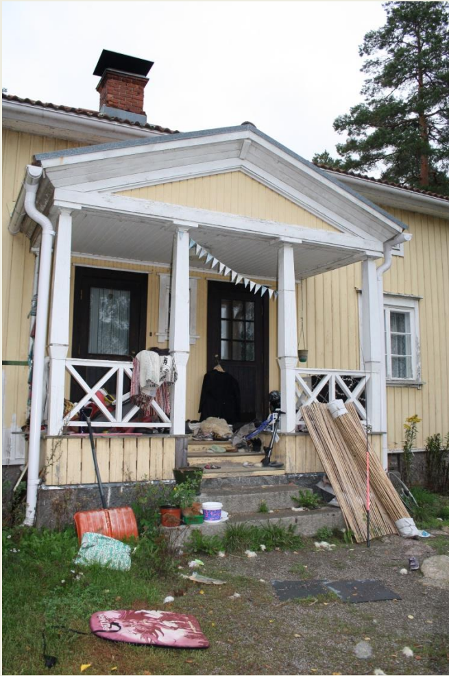
Kuva 29 Tupakan rakennuksen avokuistin päätykolmio ja kapiteelien kruunaamat puiset pilarit. MRT/2019
