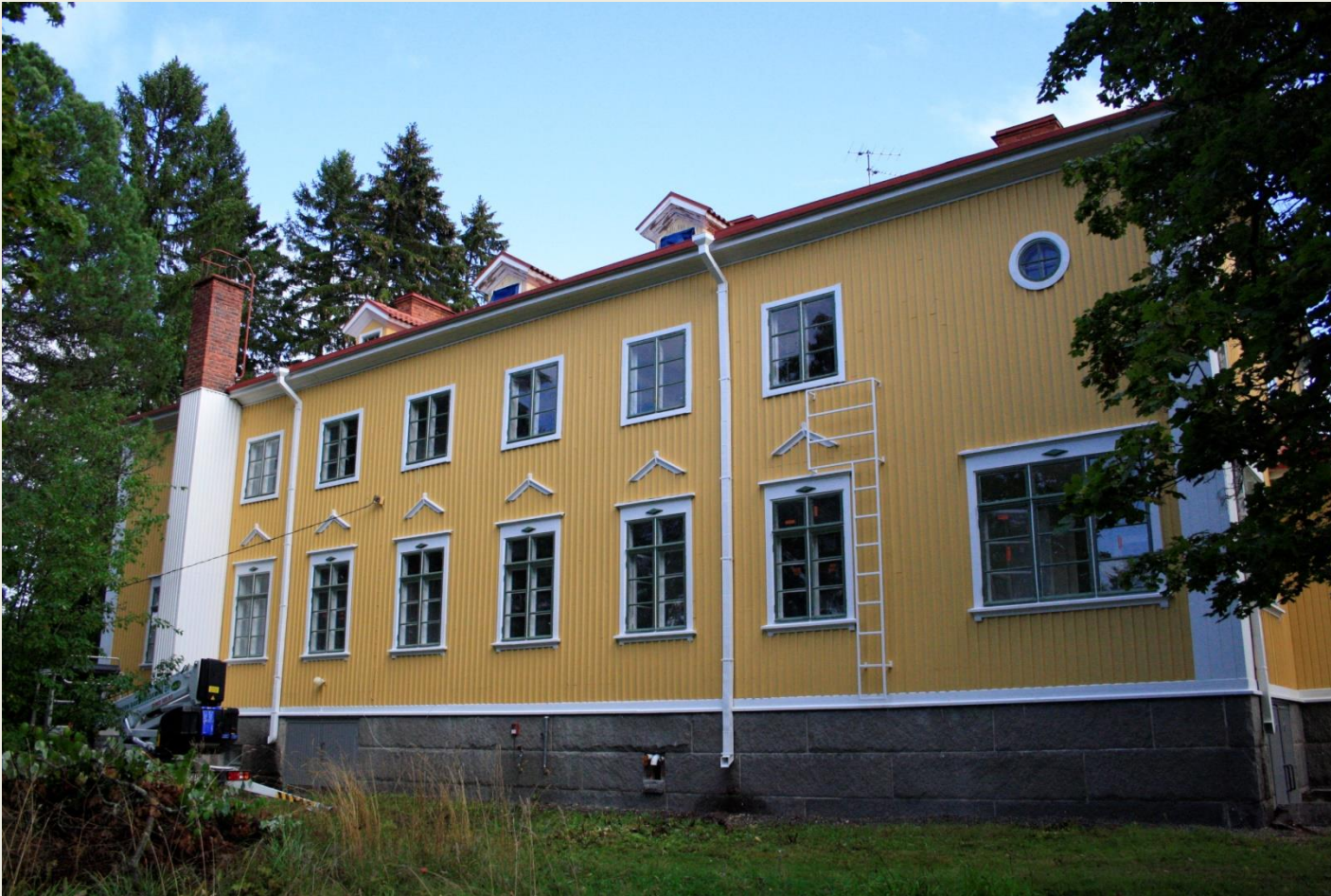
Kuva 27 Vuoden 1959 keskuslämmitysjärjestelmän vaatima hormi on sijoitettu rakennuksen takaosaan. MRT/2019.
